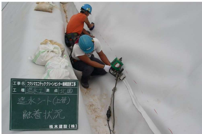
法面遮水シート溶着接合状況
