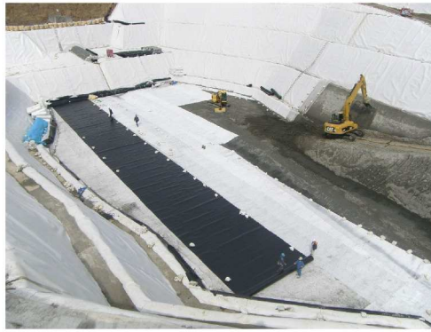
底盤部 掘削及び遮水シート敷設状況
