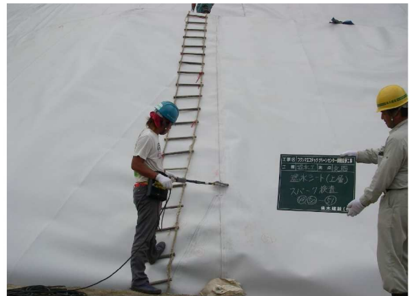
接合確認(スパーク検査)
