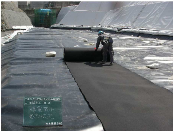
導電マット敷設状況
