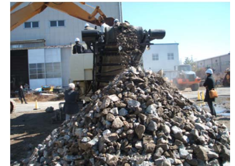
写真. サイザーによる試験破碎状況
