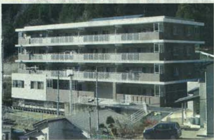
立派に完成した花露辺地区災害公営住宅
