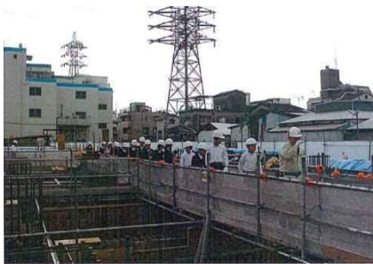
・特別養護老人ホーム新築工事の現場見学会(近隣小学生)
