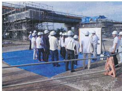
・橋梁下部工事の現場見学会(学生)
