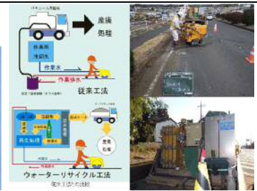
・ウォーターリサイクル工法仕様の コンクリートカッターの使用
