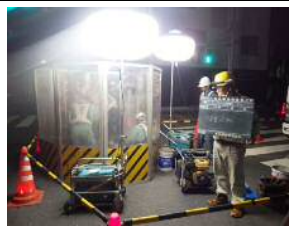
・防音パネルを設置しての取壊し 作業
