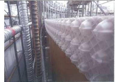
・KK シートでのコンクリート打継処理
