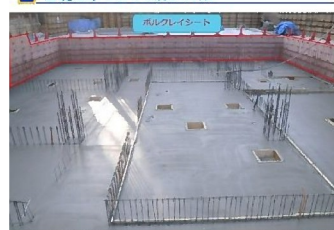
・施工状況（矢板面に貼り上げ）
