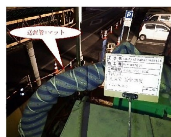
② 送泥管騒音防止マット取付け状況
