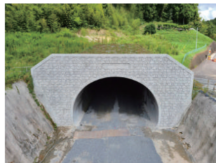
坑口部 完成写真
