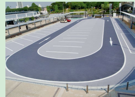
遮熱性舗装による温度上昇の抑制
