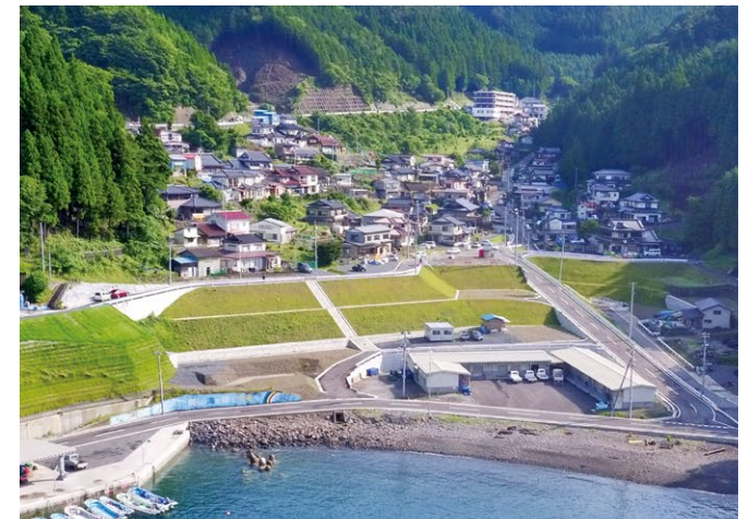
復興公営住宅地 造成(岩手県)
