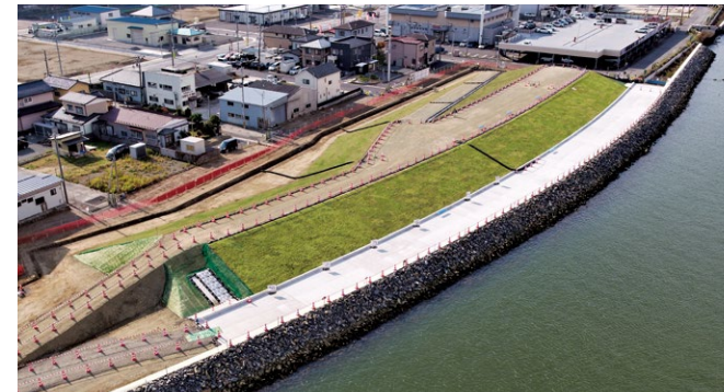
河川堤防(宮城県)
