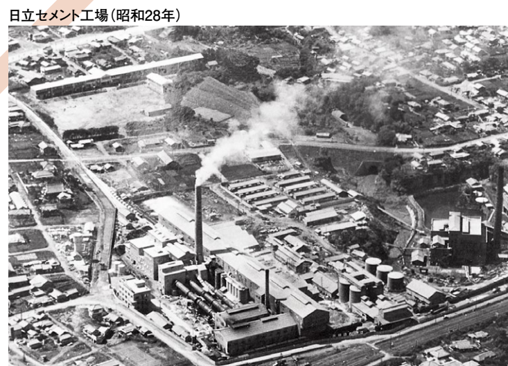
日立セメント工場(昭和28年)
