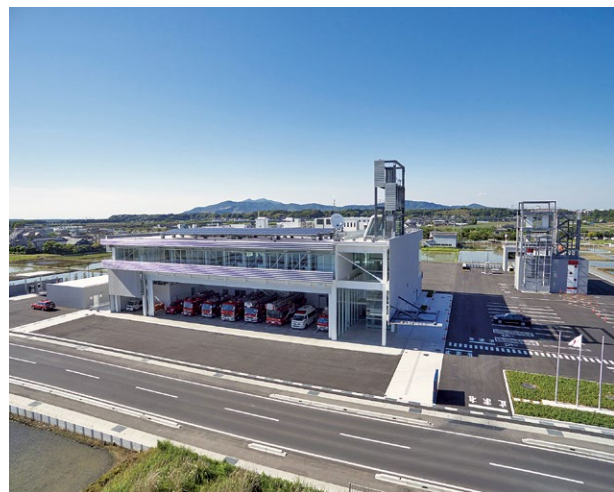
土浦市消防本部庁舎(免震構造)
