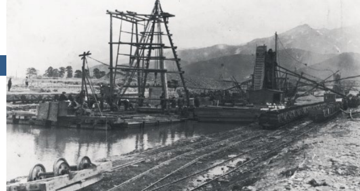
甲府飛行場工事(昭和16年)
