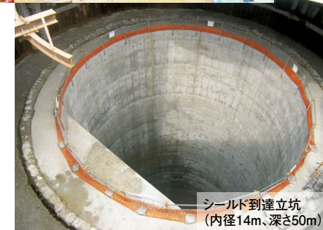
下水道立坑 ニューマチックケーソン(東京都)
