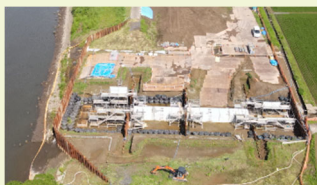
施工時の上空からの撮影画像
