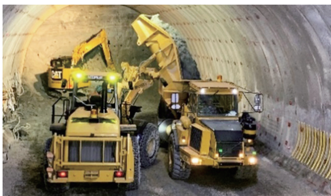
狭いトンネル内での大型重機作業
