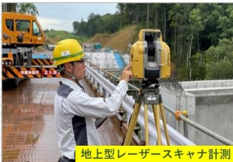
左図の機材は、360度回転しながらレーザーを照射し、ミリ単位の密度で点群データを計測します。ただし、機材の真下や構造物の裏側は計測ができないため、一定の間隔で移動します。
