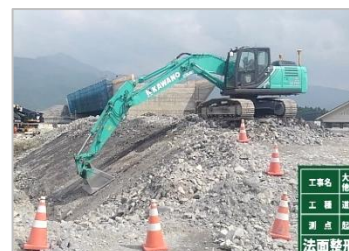
設計データをもとに施工
