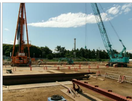
杭・山留工事中
