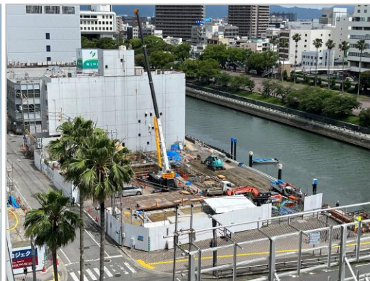
ホテル棟工事・新町川の船着き場工事
