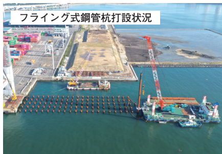
杭打ち船による鋼管杭打設状況
