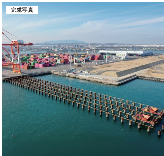
フライング式鋼管杭打設状況
